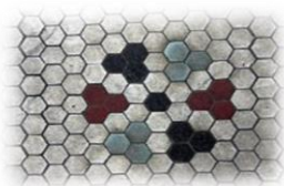
玄関床のタイル
